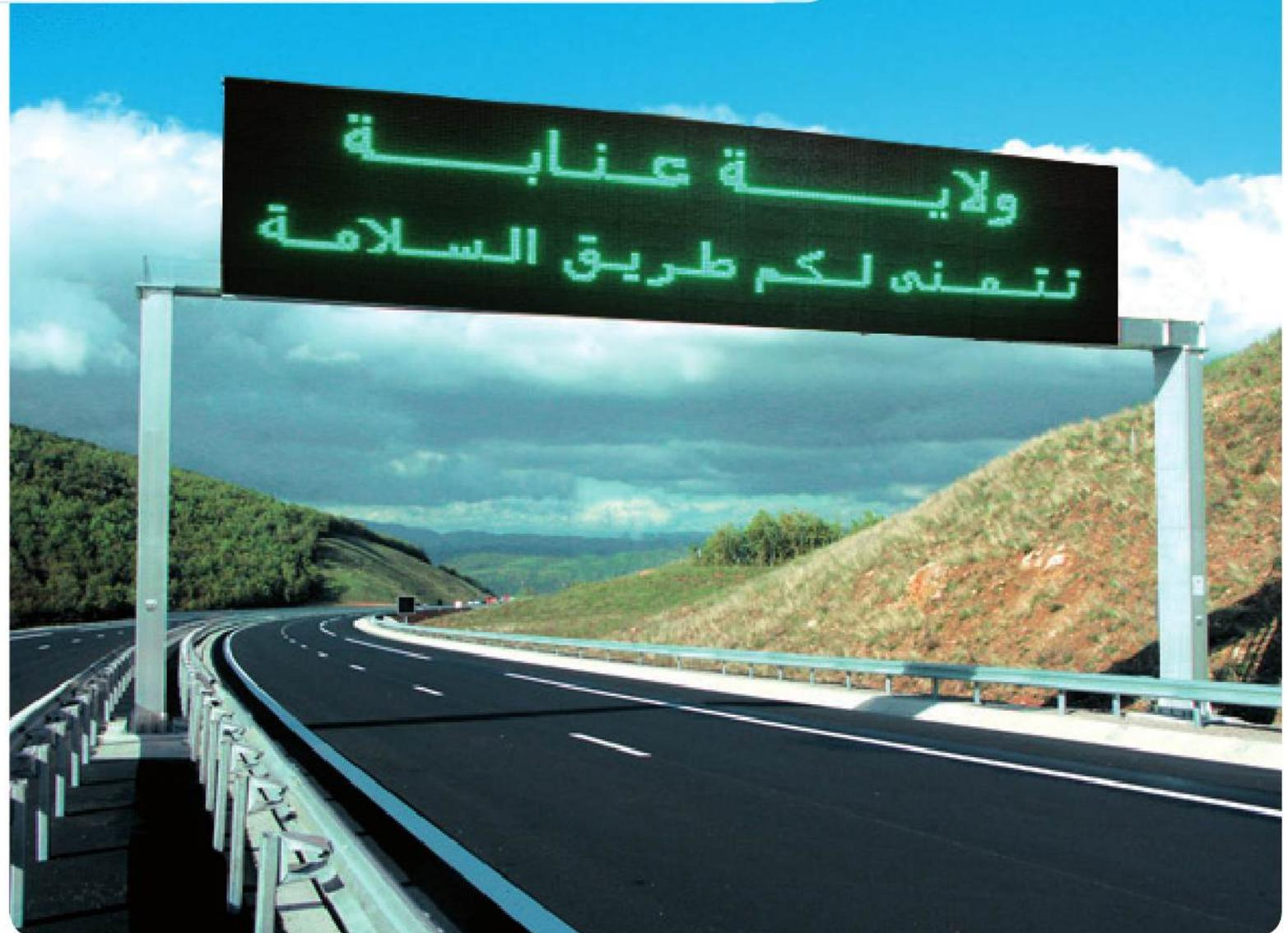
Les informations électroniques, sont réalisés avec des LED (Light Emitting Diodes).
